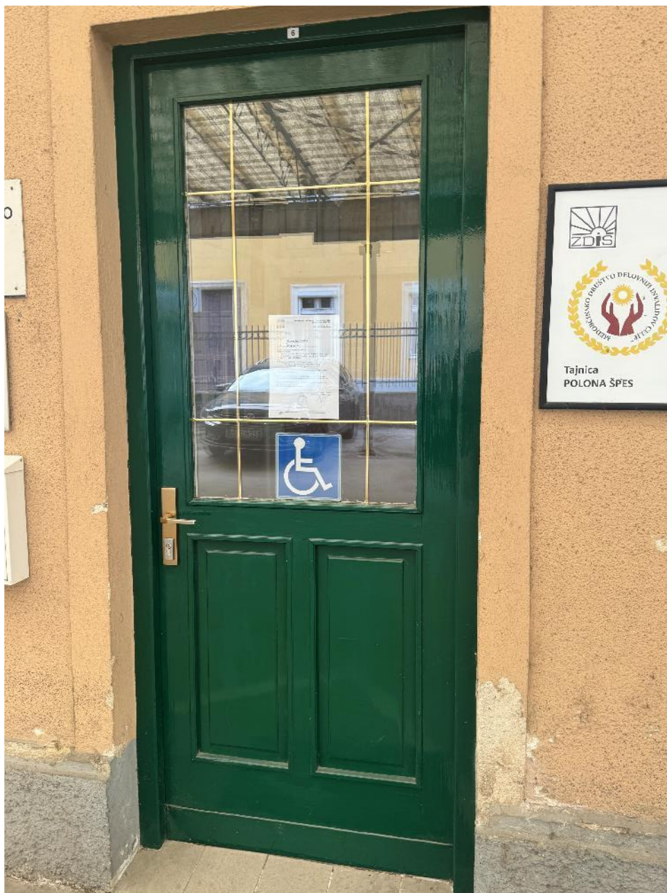
Slika 5.7: Energetsko neučinkovita lesena vhodna vrata na V fasadi
